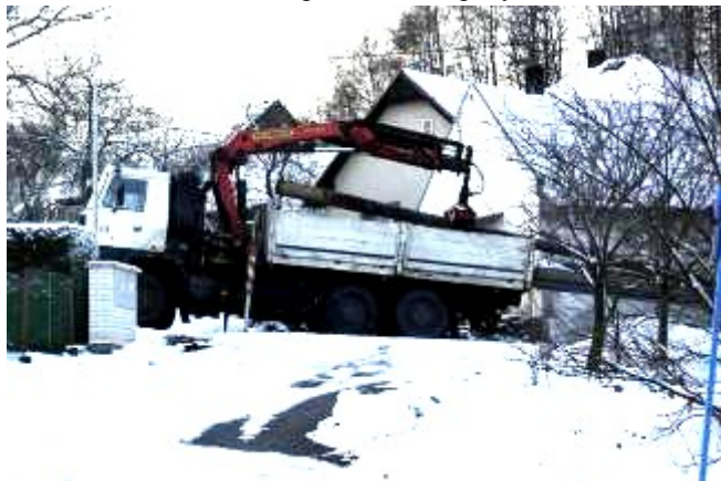
Likvidace sloupů starého vedení proběhla v listopadu
