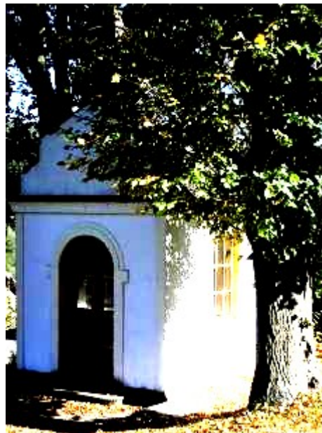
Podzemní pohled na jednu z dominant obce
