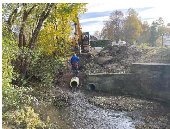
Oprava propustku říjen 2021
